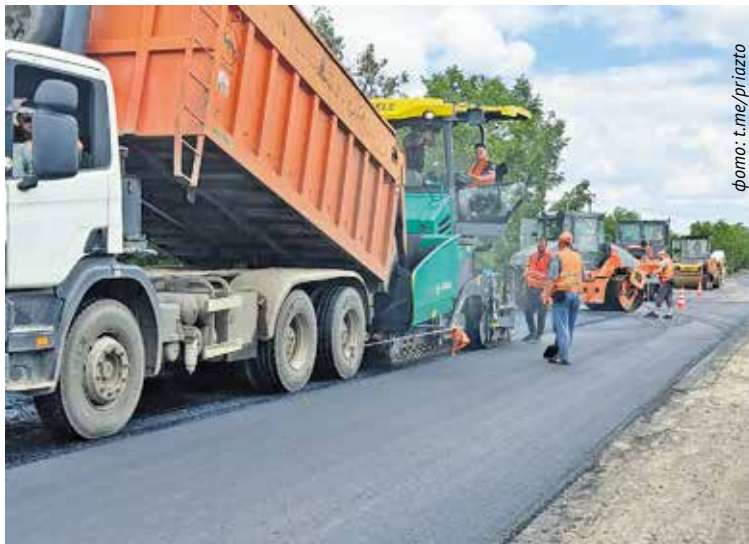
В поселке Приазовское ведется ремонт главной дороги
